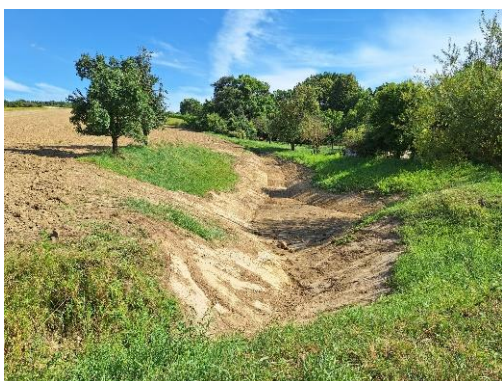
ausgebaggertes Rückhaltebecken in Haslach
